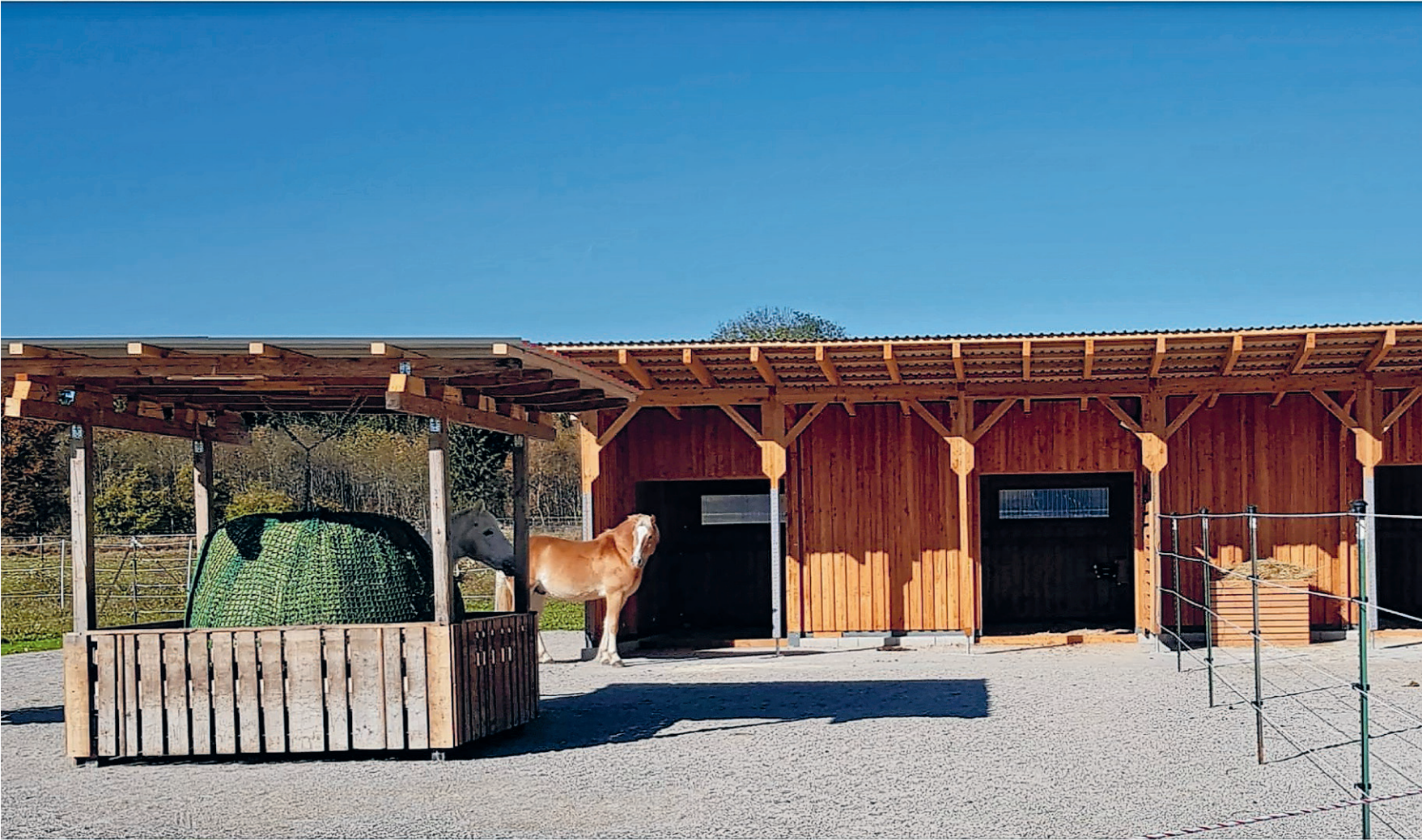
Die Nachfrage an Pferdehütten der Marke »Olaf Nielsen« hat sich enorm entwickelt. Selbst aus dem angrenzenden Ausland kommen Aufträge in den hohen Norden. In Tarp hat der Zimmermann eine neue Produktionsstätte errichtet. Foto: Privat
